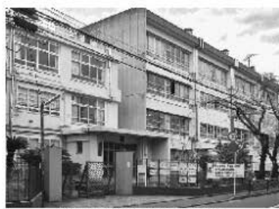
全面改装される住吉中学校
