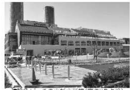
建設急ピッチの小杉小学校(市のHPより)
